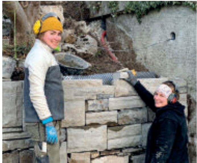
1-12 Frauenpower beim Mauerbau
